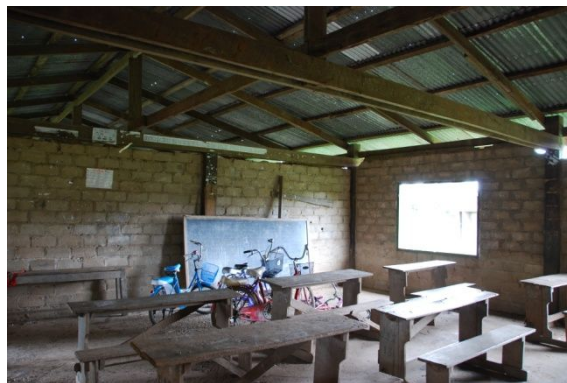
シビライ小学校の校舎の中 (ボーリカムサイ県)
