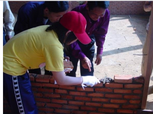
慣れない手つきで小学校の壁造り
