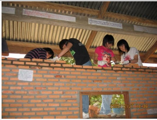
小学校建設作業ボランティア(12/27)
